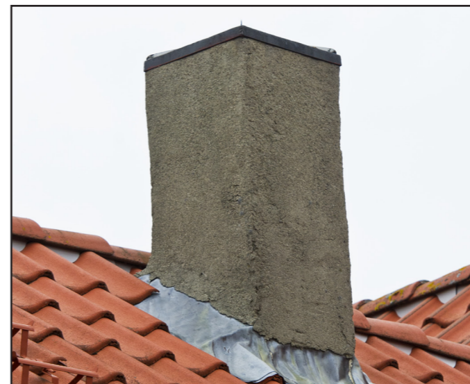
Før beslaget settes på plass, tettes det med Wakaflex. Dette er dagen erstatning for bly, og er et svært formbart, sterkt og værbestandig materiale. Når beslaget er nøyaktig produsert, er det raskt å montere.
