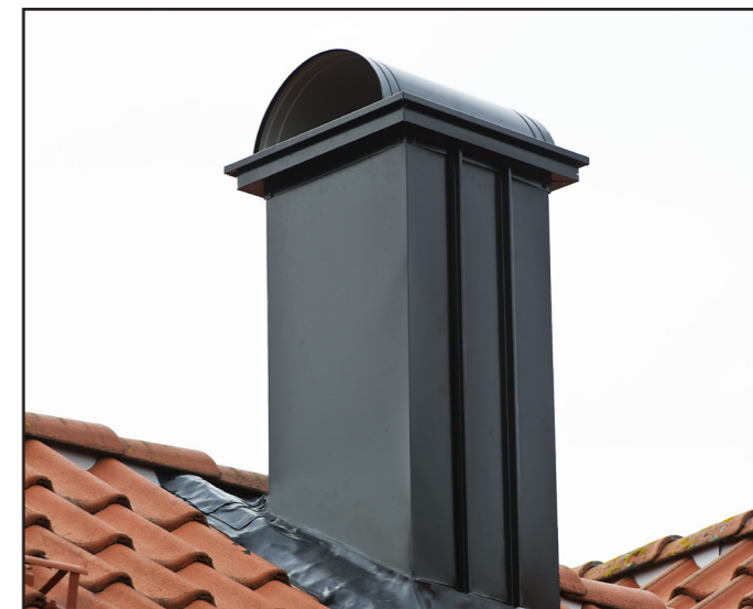
Før beslaget settes på plass, tettes det med Wakaflex. Dette er dagen erstatning for bly, og er et svært formbart, sterkt og værbestandig materiale. Når beslaget er nøyaktig produsert, er det raskt å montere.
